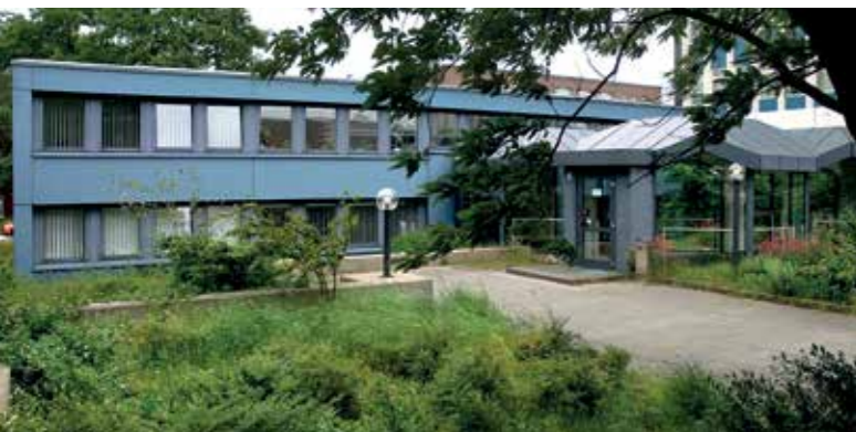
Anbau des Universitätshochhauses, Zentrale Studienberatung Foto: Jürgen Haacks © Uni Kiel
